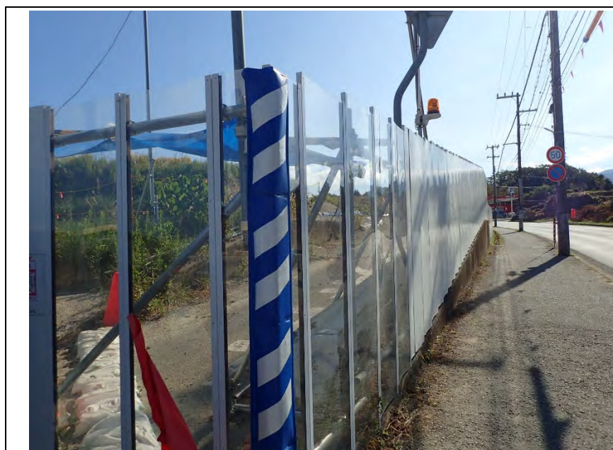
写真⑥ 遮音壁設置状況
