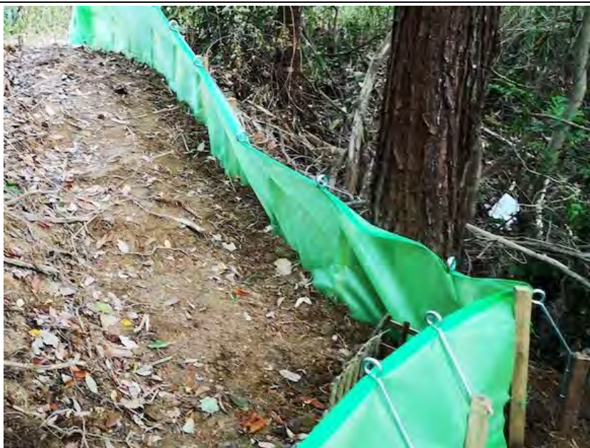
写真㉒ 流出防止柵の設置
