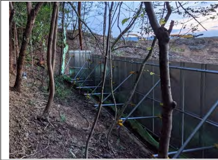
写真① 万能塀の設置
