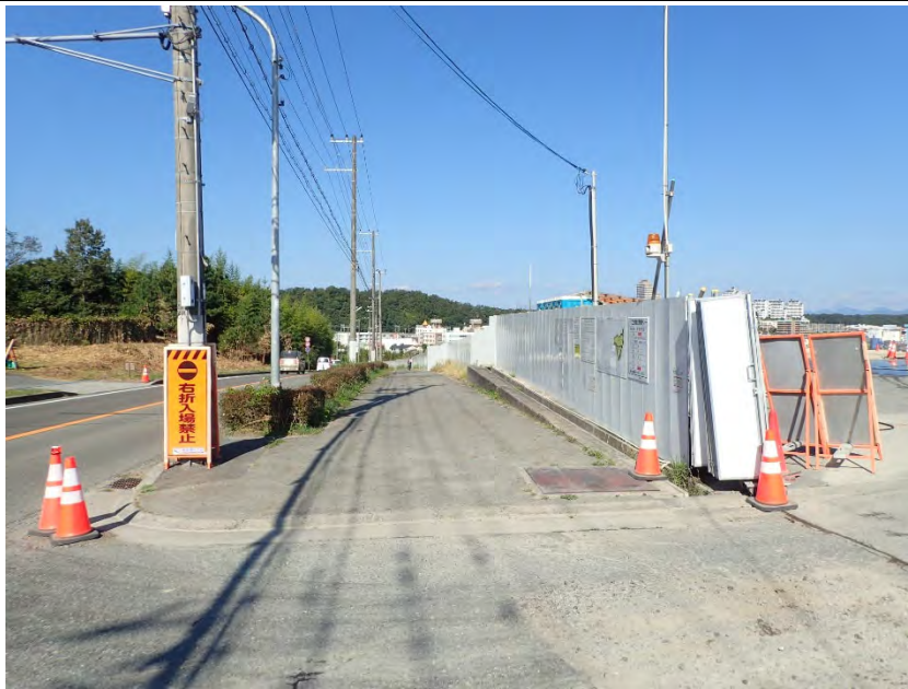
写真① 仮囲い設置状況
