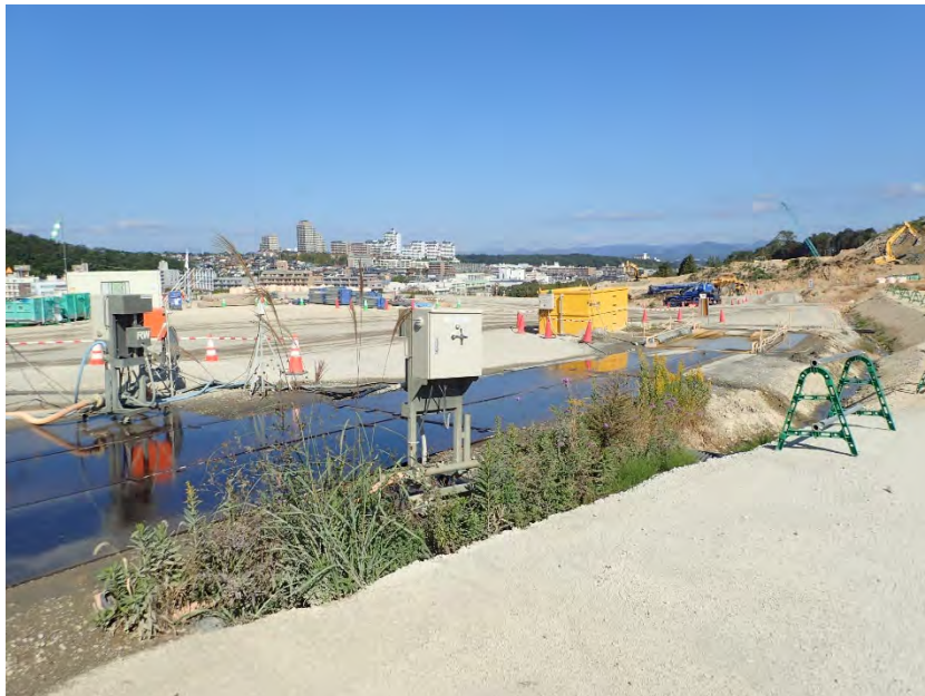
写真③ 洗車スペースの設置状況
