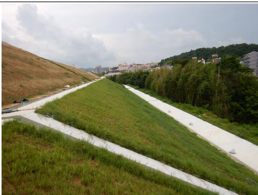
写真㉛ 法面緑化状況 (種子散布)
