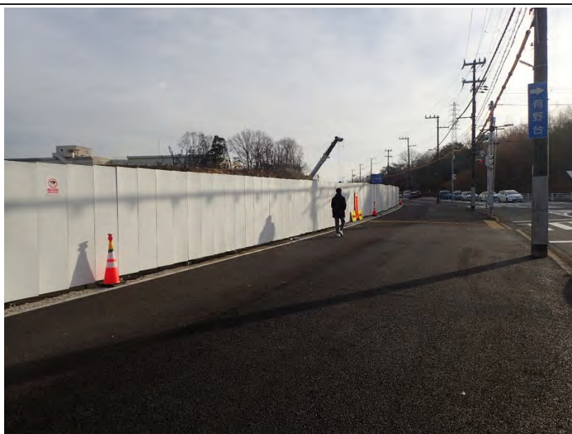
写真⑥ 遮音壁設置状況
