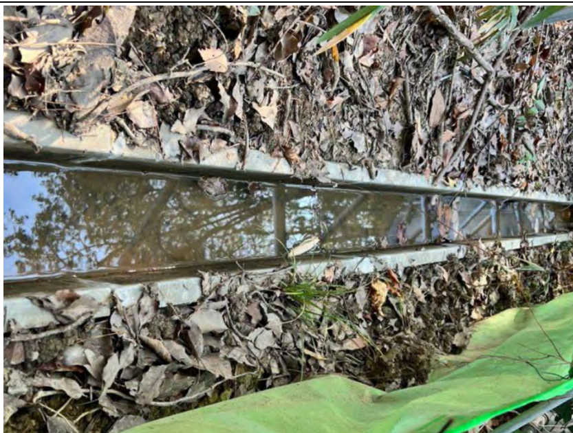
写真②⑦ 生息環境の創出 (側溝の補修)
