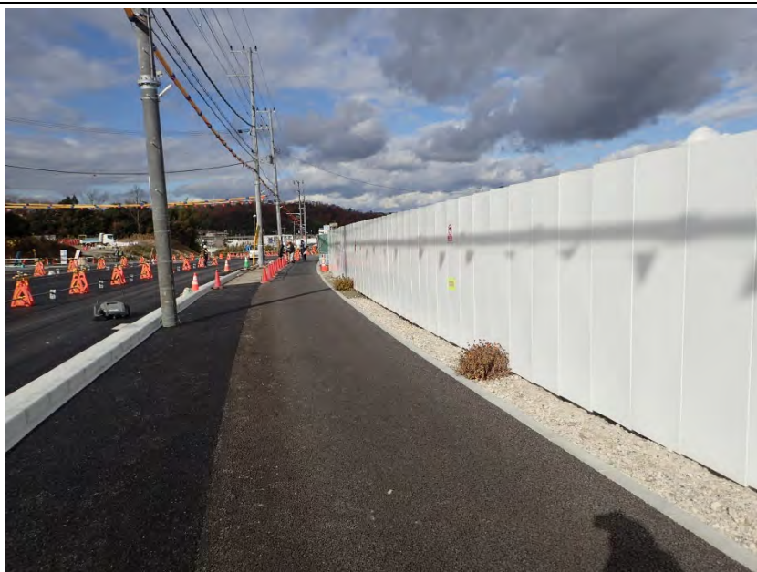
写真① 仮囲い設置状況
