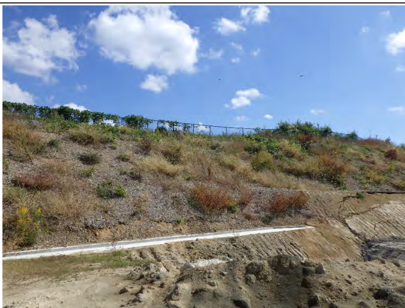
写真㉚ 法面緑化状況 (ネッコチップ工法)
